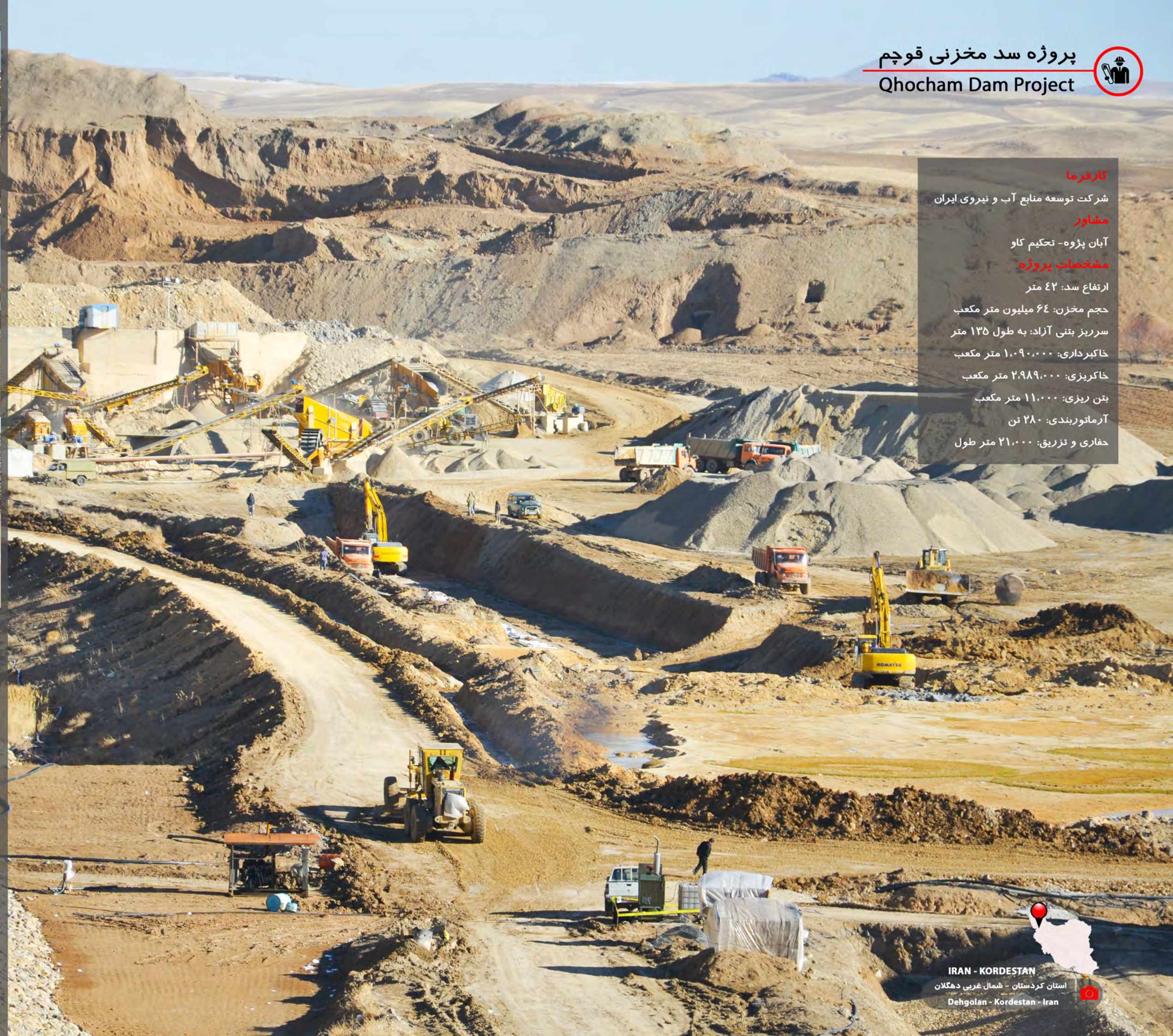
خاکبرداری پی و بدنه سد Foundation and dam body excavation
